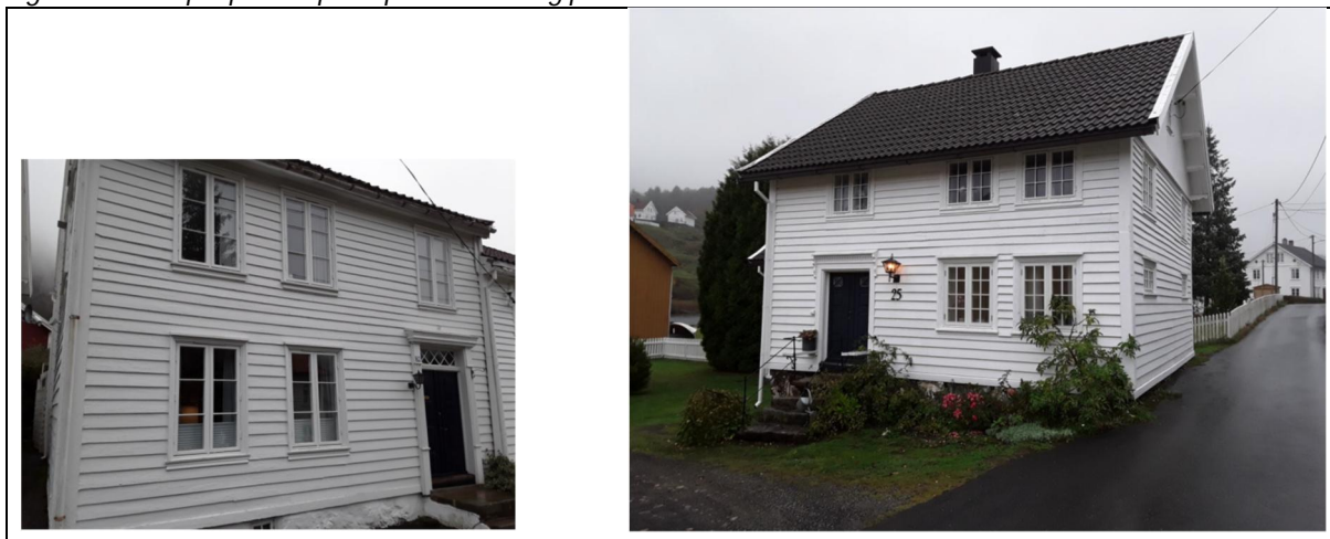
Figur 15 Eksempel på luftspenn på el-inntak og plasttakrenne
